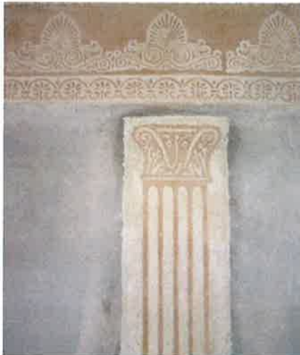
In zwei Lagen wird der Kalkmörtel aufgetragen, der in Farbigkeit und Körnung variieren kann.
